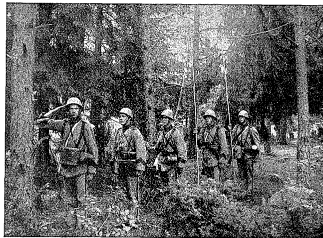
Bild 162. Färdiga till linjebyggnad.
